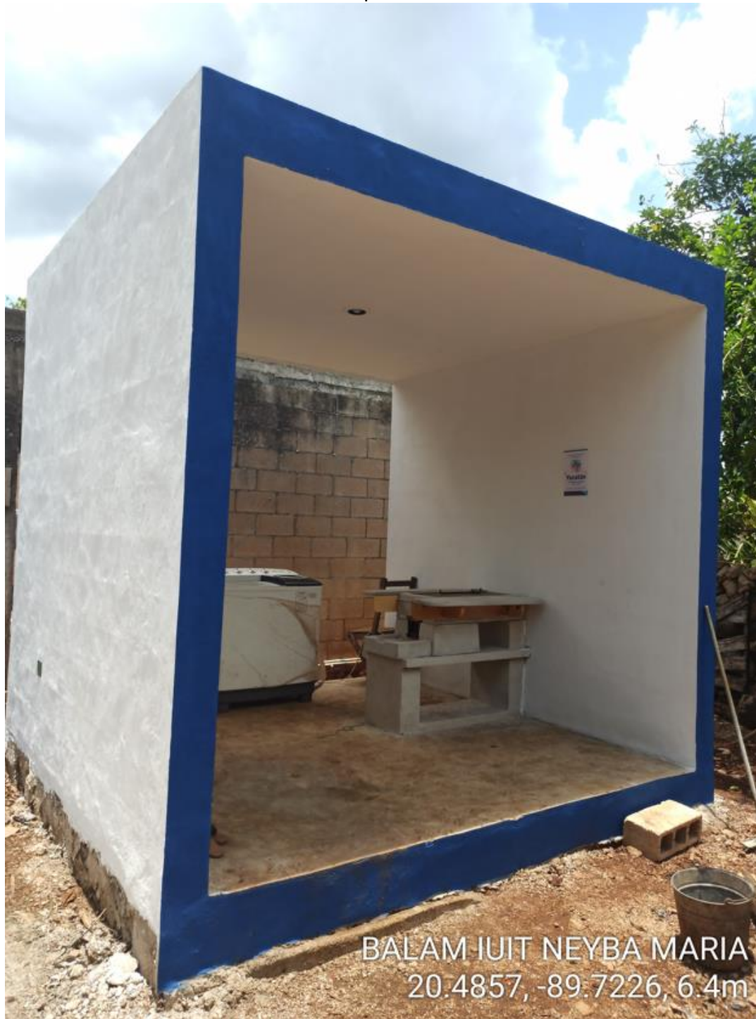
Cuarto para cocina
